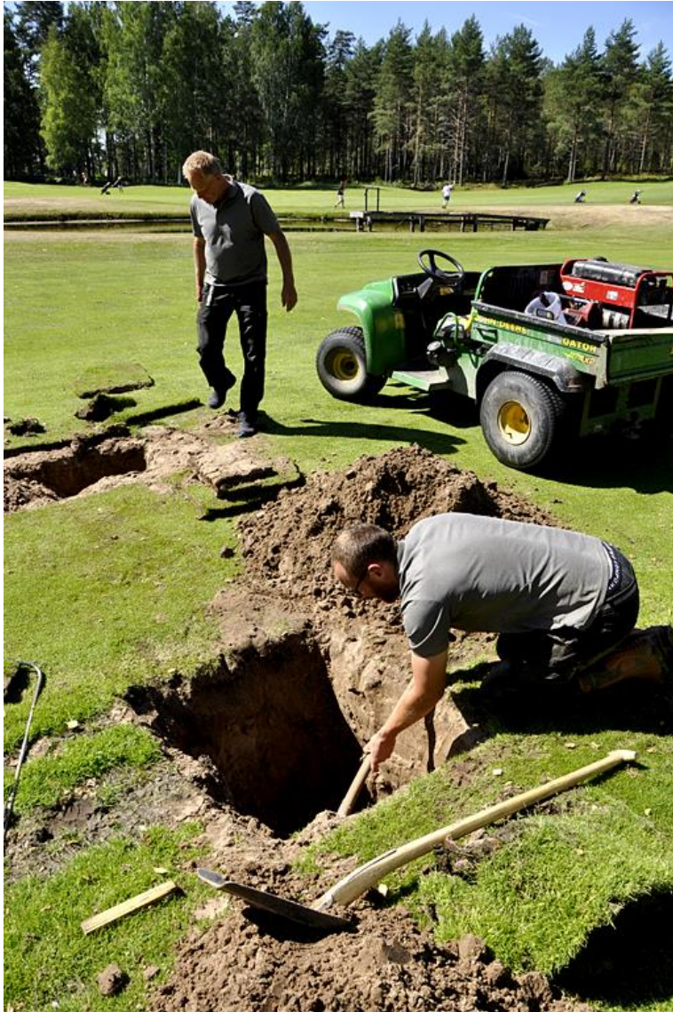
Mycket slit för Christian Svärd (närmast), Jan Lindberg och övrig banpersonal som en följd av trasiga gamla plastskarvar i bevattningssystemet runt hela banan.
